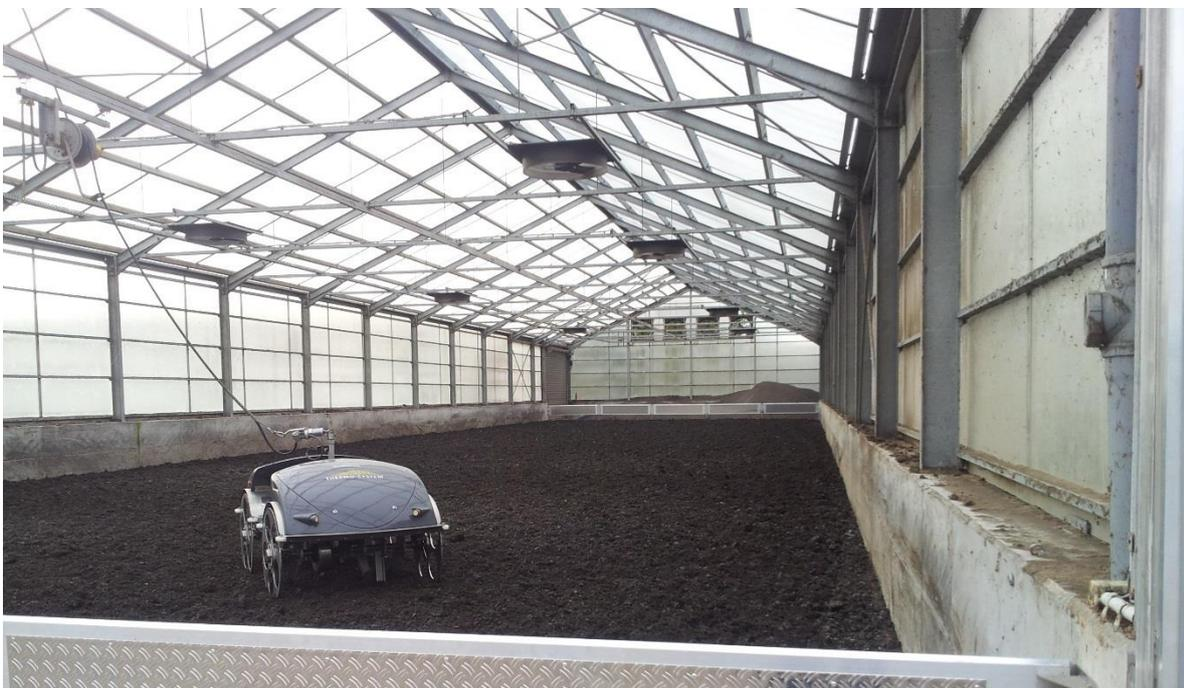
**Abbildung 3:** Solare Klärschlamm-trocknung mit ELEKTRISCHEM SCHWEIN
