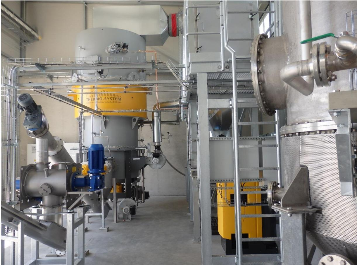
**Abbildung 6:** KLÄRSCHLAMMREFORMER mit Rauchgasreinigung
